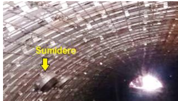
FIGURA 8 Plancha especial instalada en Obra
