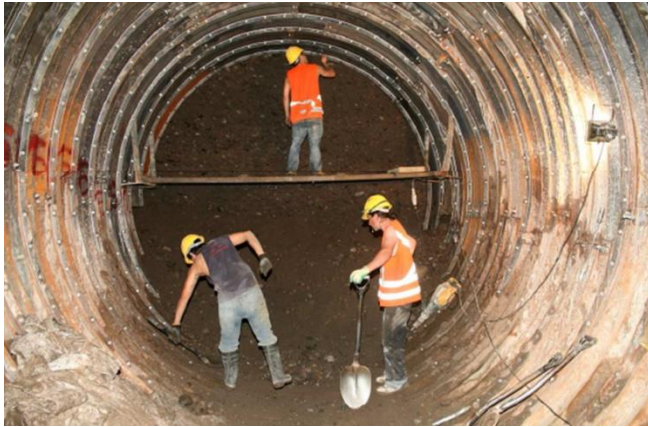
FIGURA 3 Estructura de Tunnel Liner
