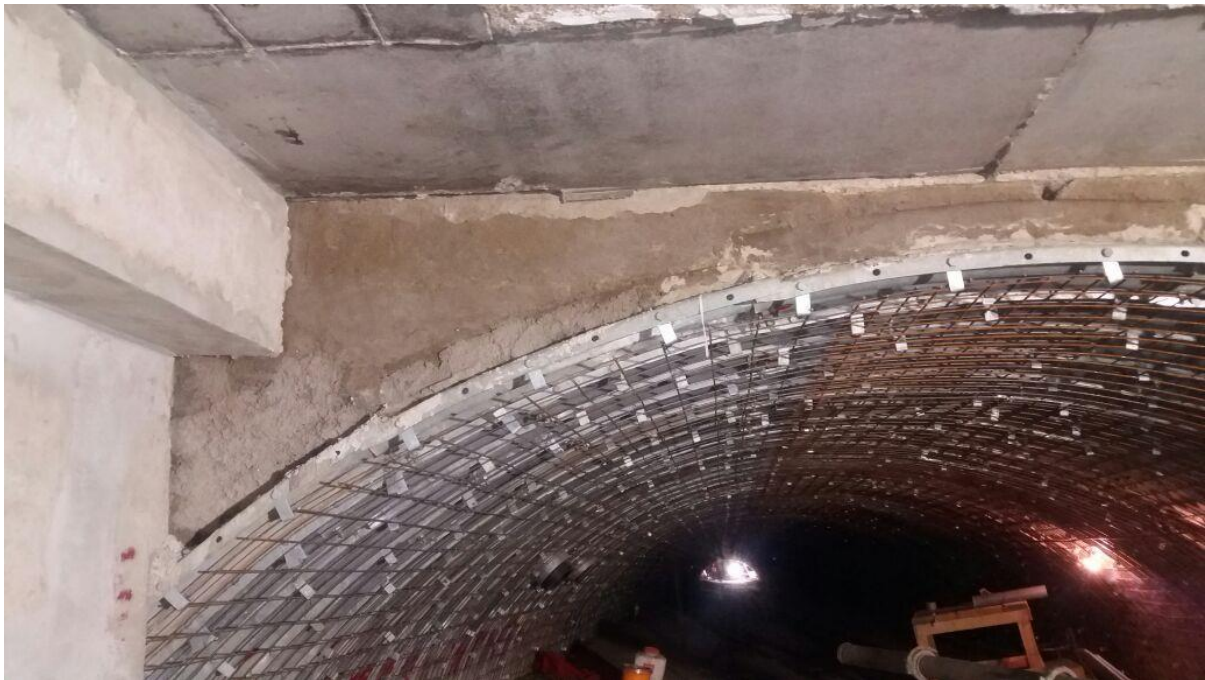
FIGURA 9 Estructura reforzada mediante el método de Relining
